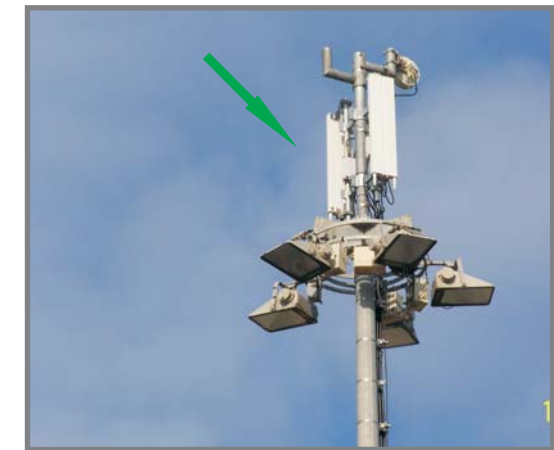
Ipotesi di dettaglio: posizionamento antenne sulla sommità del palo di illuminazione
